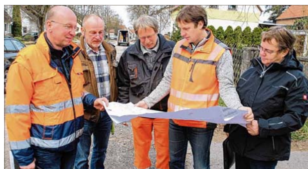
Bernd Zabel vom WWAZ, Bürgermeister Eckhard Liebrecht, Polier Lutz Gericke, Jan Salomo vom Ingenieurbüro und Bauamtsmitarbeiterin Simone Städter (von links) beim Lokaltermin. Foto: Detlef Eicke
