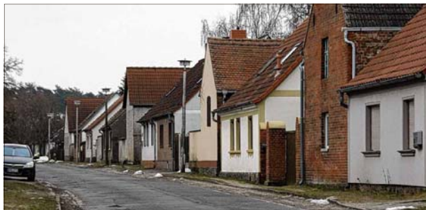
Mit 350 000 Euro Fördermitteln aus dem Rele-Programm wird die Lindenstraße in Lindhorst grundhaft ausgebaut. Foto (2): Burkhard Steffen
