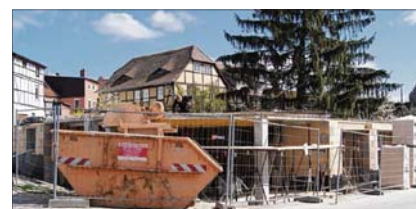
Das Haus in der Friedensstraße 37 wächst. Foto: Gudrun Billowie
