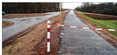
Fertig: Deichabschnitt 2b samt Wendehammer. Foto: G. Billowie
