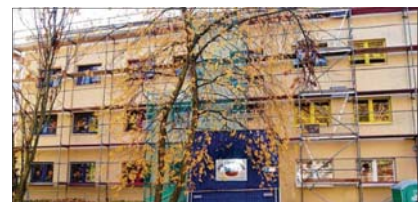
Die Dachdecker arbeiten auf Hochturen.
