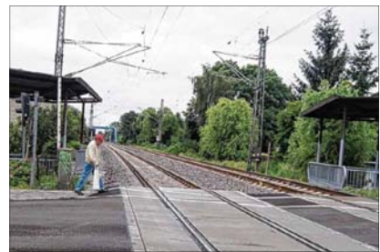
Bis Ende des Monats soll der sanfte Anstieg zum Gleisbett hergestellt sein. Fotos (2): Gudrun Billowie
