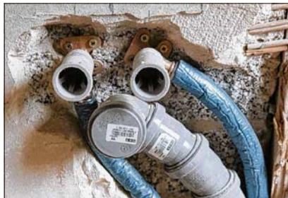
Kleiner Anschluss, großer Streit: Rohre einer Sanitärinstallation für den Abwasseranschluss in einem Osteroder Haus. Foto: dpa
