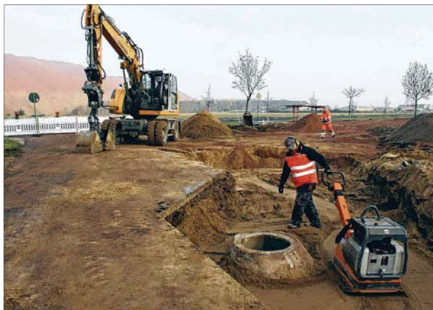
Für den geplanten Sporthallenneubau in Loitsche haben die Erschließungsarbeiten begonnen. Bauarbeiter aus Genthin errichten die Wasser- und Abwasseranschlüsse. Foto: Burkhard Steffen
