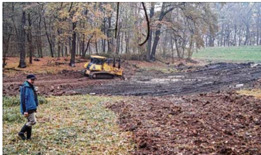
Alfons Hesse zeigt, an welcher Stelle landseitig des Elbdeichs Laichgewässer entstehen. Das Areal wird so tief ausgehoben, dass es fast ganzjährig Wasser hält.
