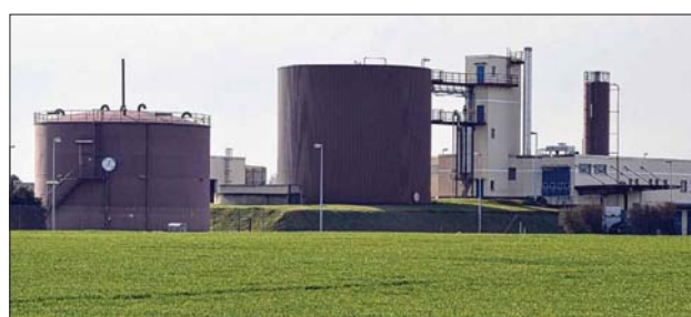
Das Klärwerk Calbe ist ein Beispiel für den hohen Investitionsbedarf von Zweckverbänden. Das Werk reinigt das Abwasser von Calbe, Barby und Nienburg. Foto: Andreas Pinkert
