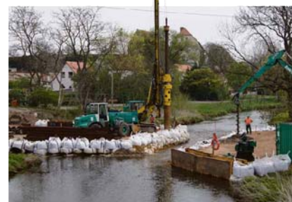
Derzeit wird das Fundament für den mittleren Brückenpfeiler vorbereitet. Foto: Gudrun Billowie
